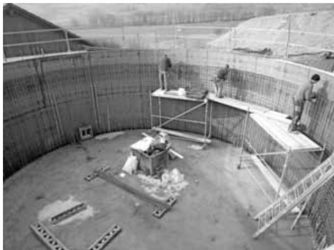
Nachdem die Bodenplatte betoniert und die Rundschalung gestellt war, sind die Mitarbeiter der Fa. Leuthe derzeit mit den Armierungsarbeiten beschäftigt. Das Rückhalte- und Pufferbecken hat einen Durchmesser von 10 Meter und eine Höhe von 3,50 Meter.
