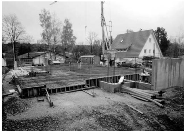
Am vergangenen Montag wurde von den Mitarbeitern der Baufirma die Bewehrung (Baustahl) eingebaut und am Dienstagnachmittag die Bodenplatte betonierte.
