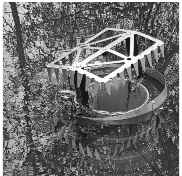
mutwillig beschädigter „Bibergator“
