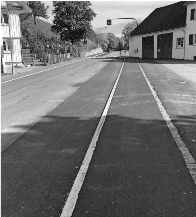
Ebenso war das Teilstück beim alten Bauhof so schadhafte, dass es erneuert werden musste. Diese Maßnahmen waren insbesondere notwendig, um Gefahrenstellen wie Löcher, abgebröckelte Randsteine, hochstehende Schächte etc. zu neutralisieren.
