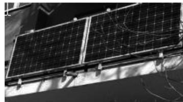
Die Möglichkeit mit Solarmodulen an Balkon, Hauswand oder sonst wo einen Teil seines Stromes selbst zu gewinnen ist denkbar einfach. Der im Solarmodul erzeugte Strom wird über eine spezielle Steckdose in den Stromkreis
