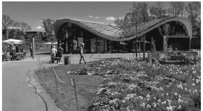
Neuartige Pavillon-Dachkonstruktion (mit Hanf verarbeitet)
