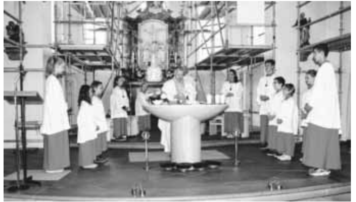
Auch zwischen den Gerüstteilen ist Andacht möglich.
