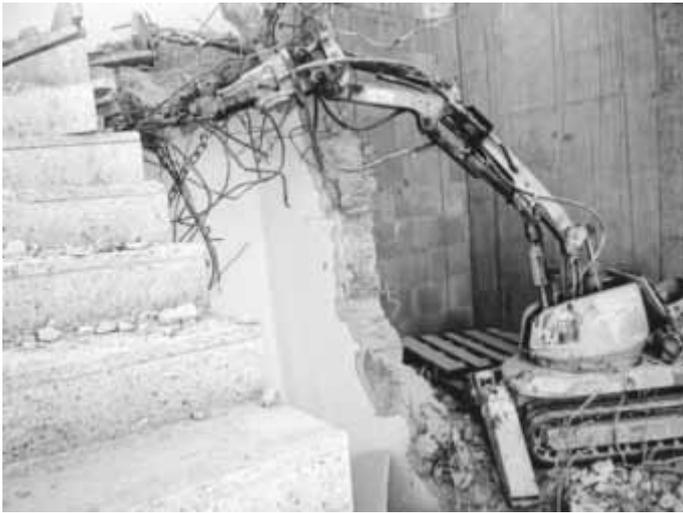
Im Dorfgemeinschaftshaus ist der Rückbau der Treppen- und Aufzugsanlage in vollem Gange. Dies geschieht mit einem ferngesteuerten Abbruch-Roboter. Das Abbruchmaterial wird über die frühere Zugangstreppe auf der Westseite zum Container transportiert. An dieser Stelle entsteht später der aufgefüllte Gartenbereich.
