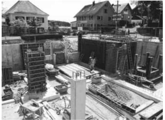
Im Neubau wurden zwischenzeitlich die Außenwände der Tiefgarage, der Aufzugsschacht und die Kellerräume betoniert. Nun beginnen die Schalarbeiten zur Kellerdecke.
