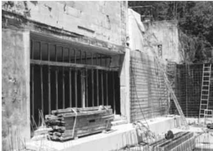
Auch wurde die Verbindung von der alten zur neuen Tiefgarage hergestellt. Dafür wurde eine Öffnung von 5.00 x 2,20 m in die bestehende Betonwand gesägt.
